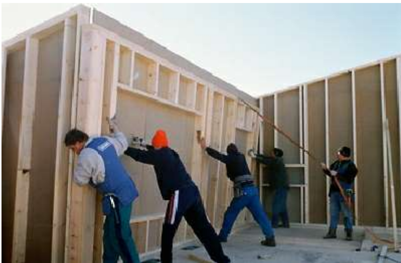
A képen látható, hogy a nyílások utólag kerülnek kivágásra, mert így merevebb és alaktartóbb a keret, ami a szerkezet végleges elkészítéséig bír jelentőséggel.
